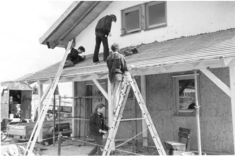
beim Bau des Vordaches, Ostern, 1995
