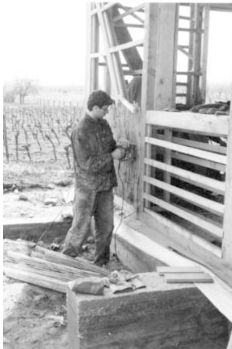
Anbringen der Schilfrohmatten
