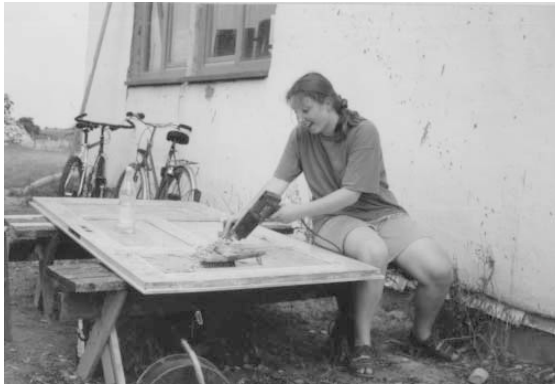
beim Ablacken einer Tür,
