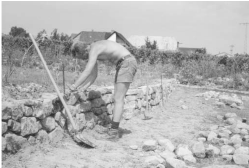
Anlegen einer Trockenmauer
