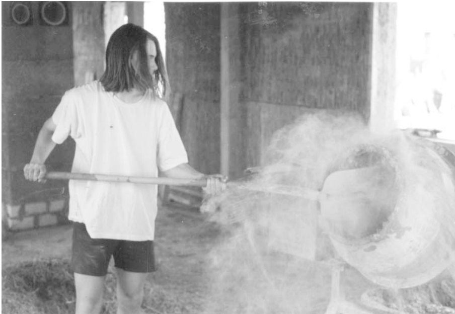
Herstellen des Lehm-Sand-Holzhäcksel-Gemisches im Betonmischer, 1993
