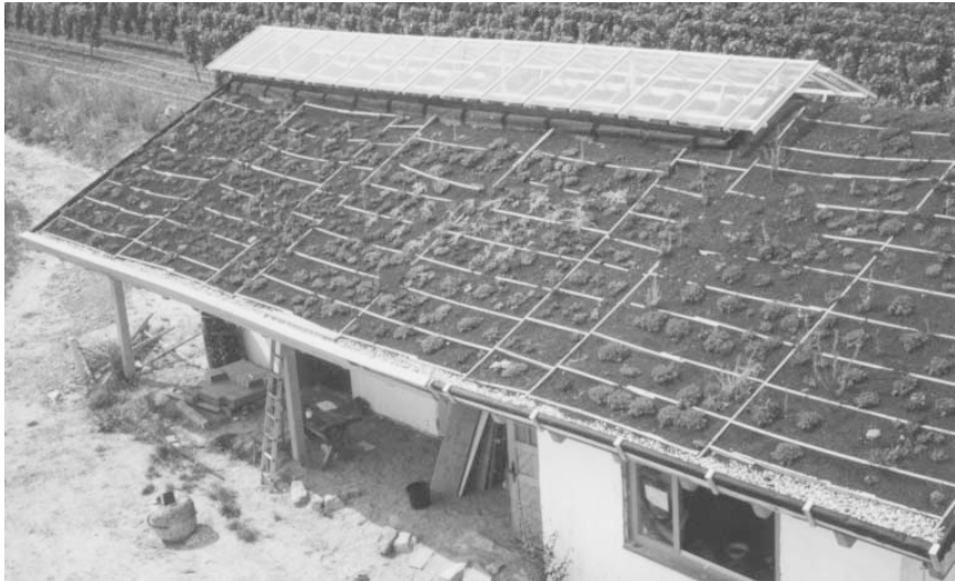
Blick vom Schornstein auf das Sanitärgebäude, 1993
