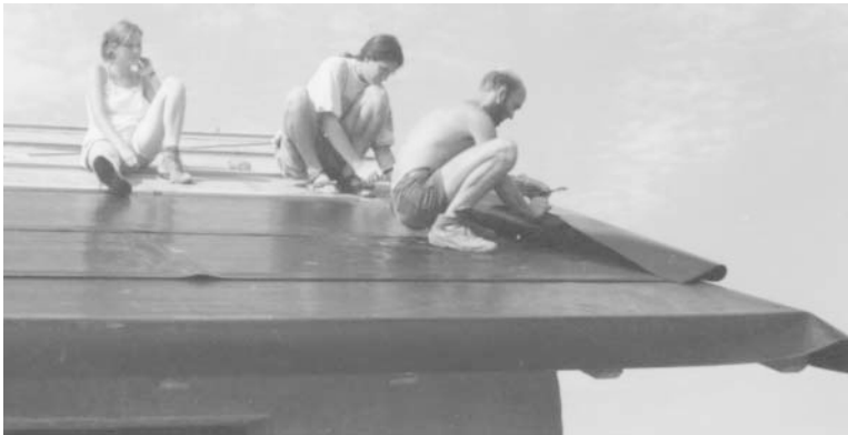
Befestigen der Dachfolie, 1993
