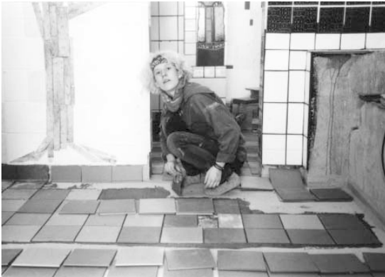
beim Verlegen der Bodenfliesen, 1996
