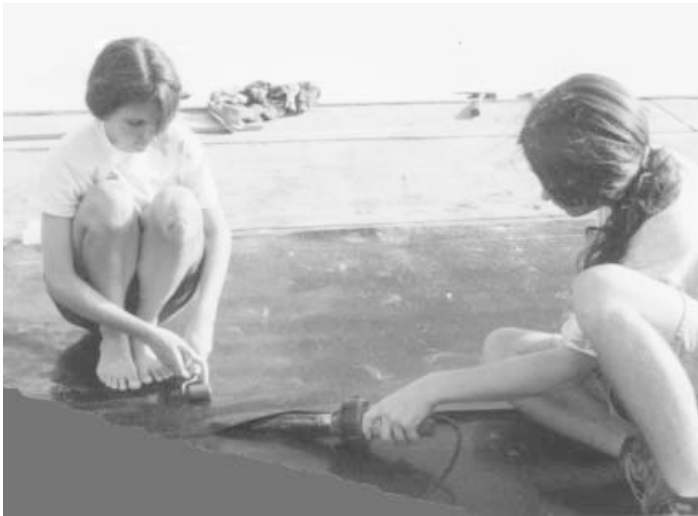
Verschweißen der Dachfolie, 1993
