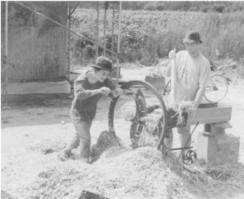
Strohhäckseln für den Unterputz, 1994
